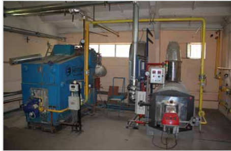
Парогенераторы на газу
